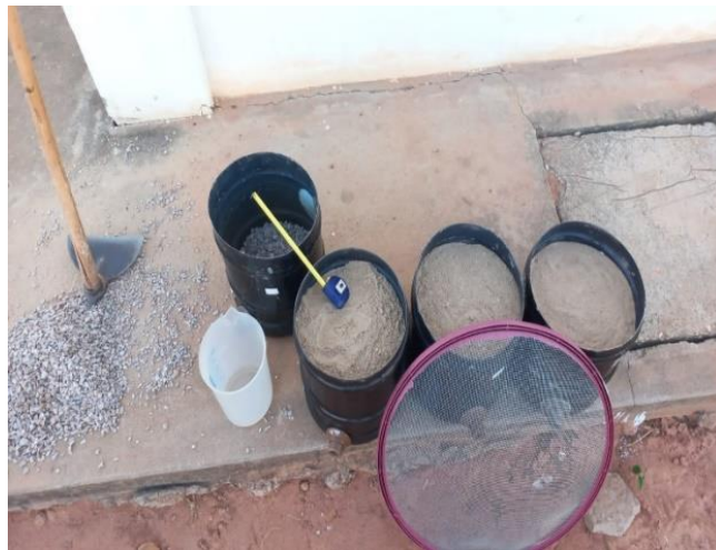
Figura 19 - Execução dos filtros de bancada
